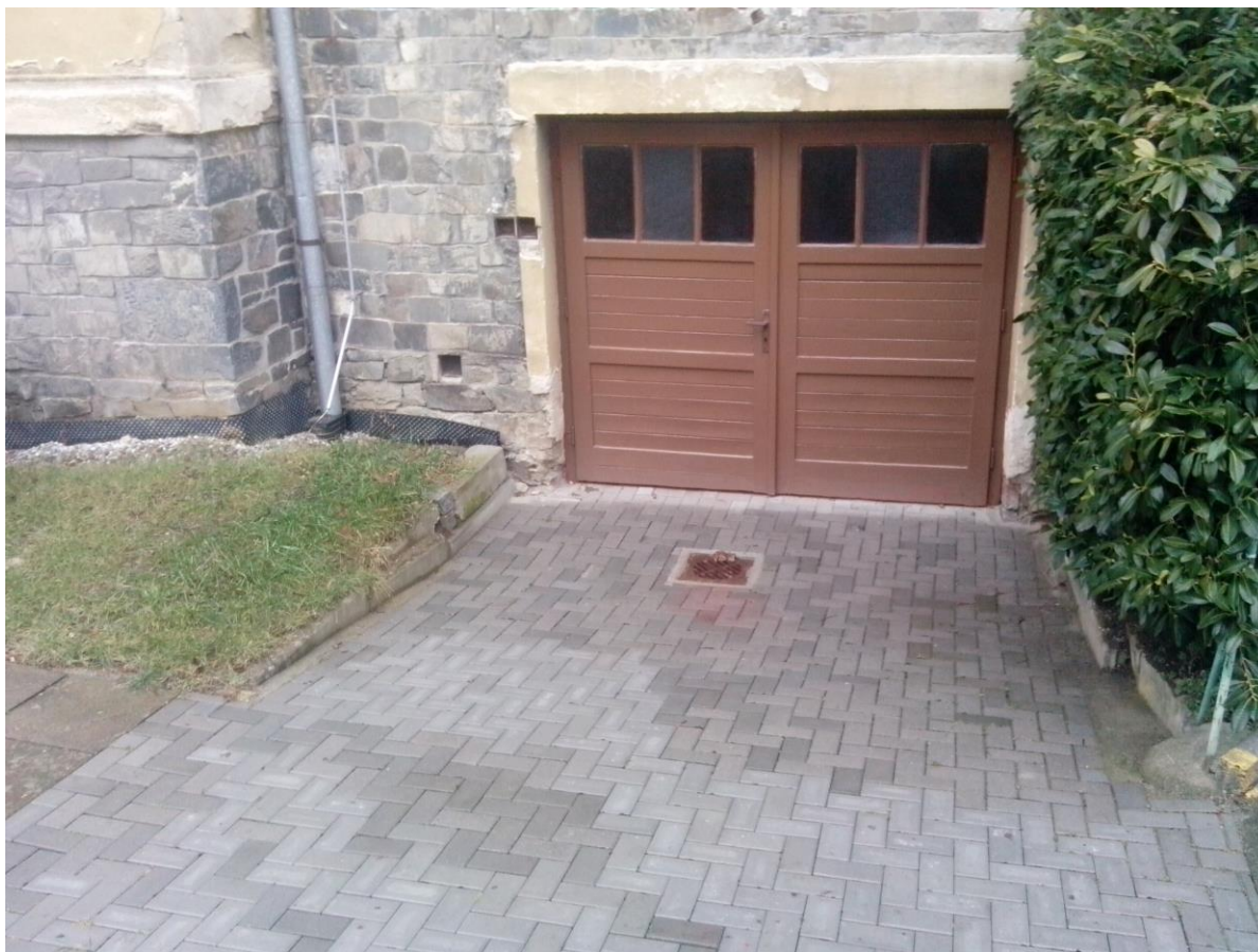
Rekonstrukce kanalizace dešťové vody, chodník a oprava garážových vrat
