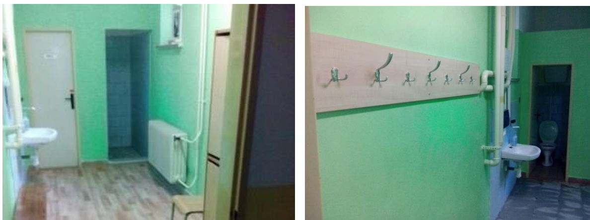
Rekonstrukce šatny – lino, vymalování, skříňky, věšáky
